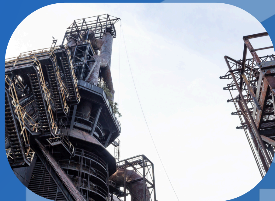
Сооружения промышленного комплекса
